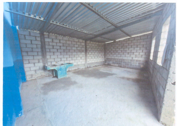
Foto 2: Reparación o sustitución de área de cocina
