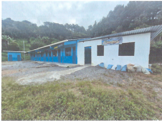
Foto 3: Losa de Patio
