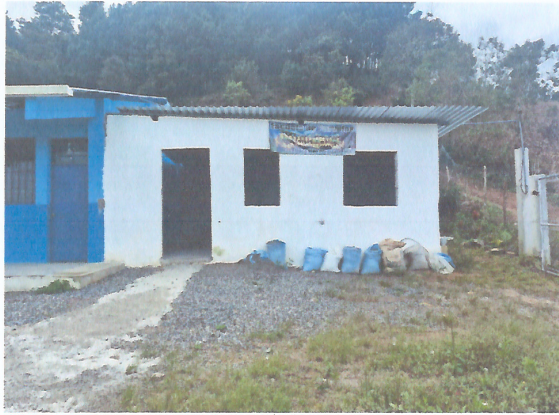
Foto1: Reparación o sustitución de área de cocina
